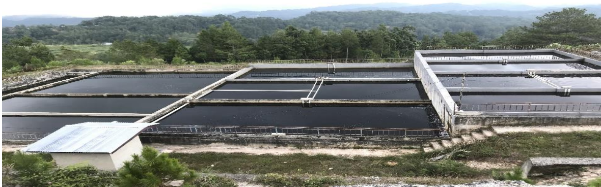
Gambar. Lokasi Instalasi Pengolahan Air Limbah di TPA Karua
